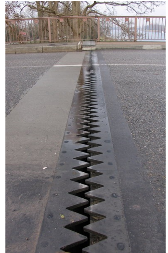
Joint de dilatation thermique d'un pont
